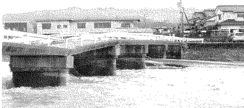
通行止めが続く被災直後の徳瀬橋
