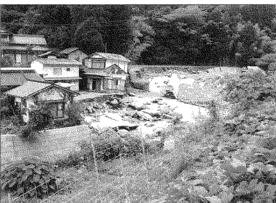
上の写真は、6年前、山の崩落で大きな被害となった斜面に水路や吹付などの対策を施工した所。こんどの豪雨で左側が崩落。
