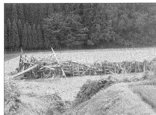
上の写真は、小野川の中に設置された流木をとめる鉄の工作物。大量の流木が止まっている。
