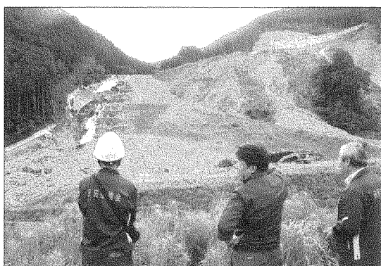
上の写真は、6年前、山の崩落で大きな被害となった斜面に水路や吹付などの対策を施工した所。こんどの豪雨で左側が崩落。
