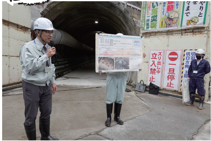
▲ 大量の湧水が出て工事がストップしている工事現場の状況を説明する県の担当者 (避難坑の入り口、2月15日)
